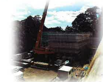
配水池築造工事
